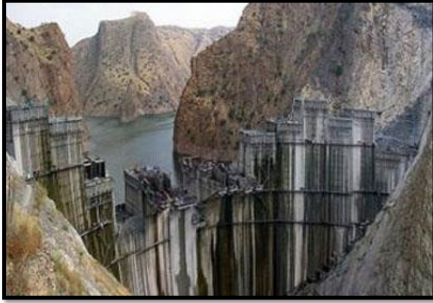
شكل رقم (٩) صورة لطبيعة مكان بناء سد النهضة
