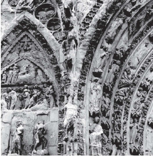
شكل ٢-٢: الدمار الذي ألحقه المطر الحمضي بواجهة كاتدرائية ريمس. 2
