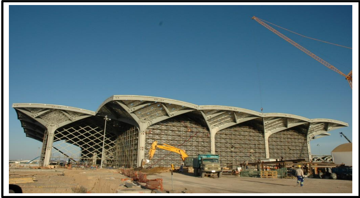
شكل رقم (١٠) صورة لمشروع محطة قطار الحرمين بجدة.
