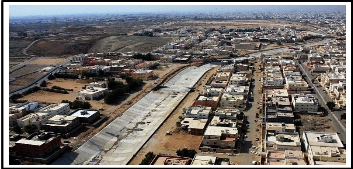
شكل رقم (١٦) صورة لإنشاء مصارف السيول بحدة
