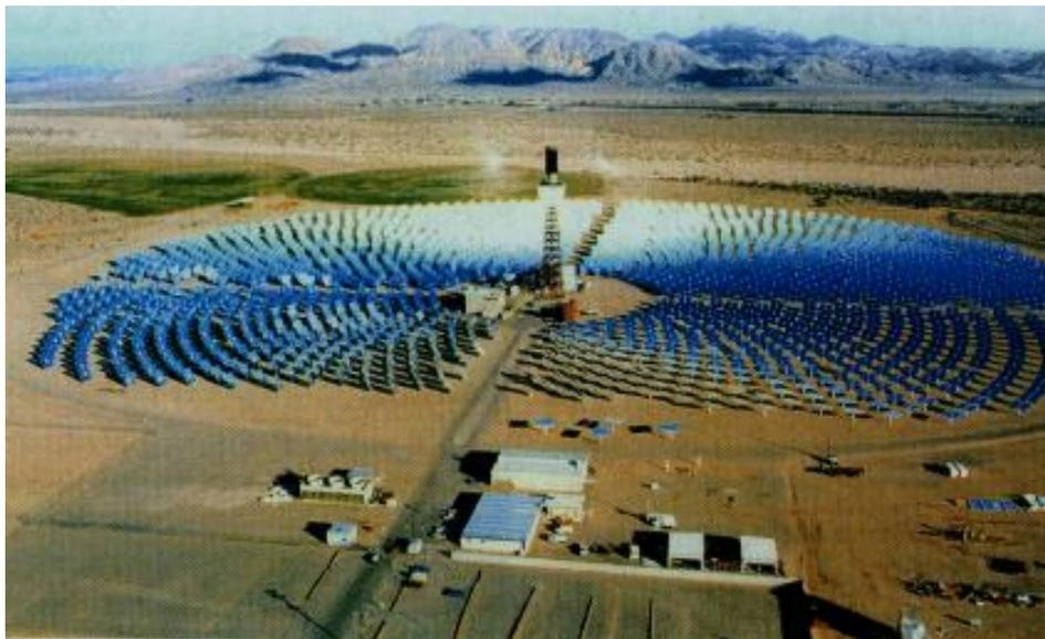
شكل (2-20): محطة توليد كهربائية تستخدم المراكز الشمسية
